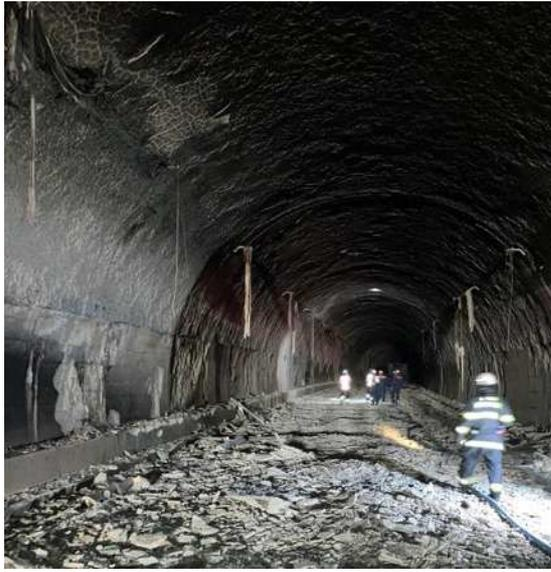
トンネル内部の焼損状況
