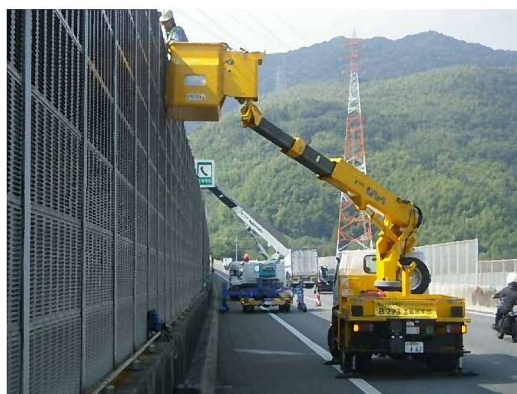
《落下物防護柵設置作業イメージ》
