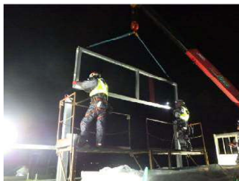
《落下物防護柵設置作業イメージ》
